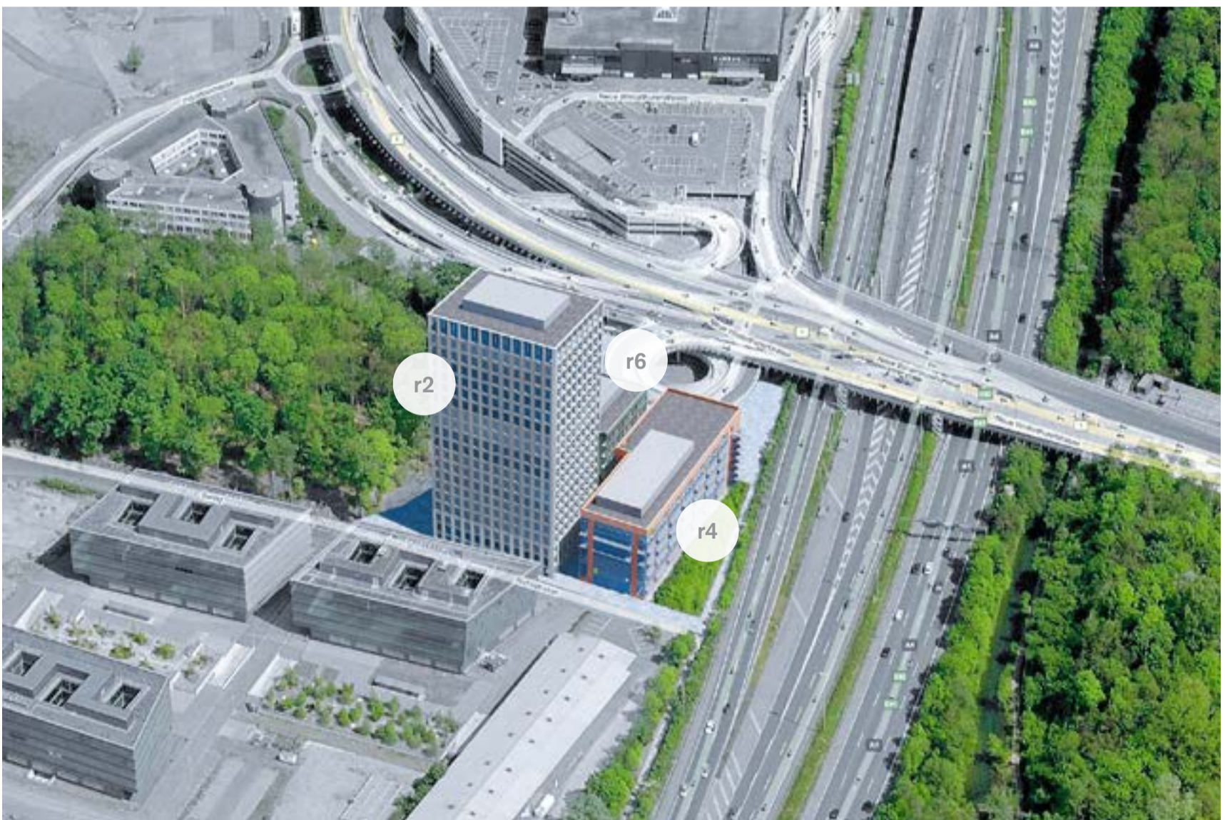
Bürohochhaus (r2): Fertigstellung im Sommer 2019.
