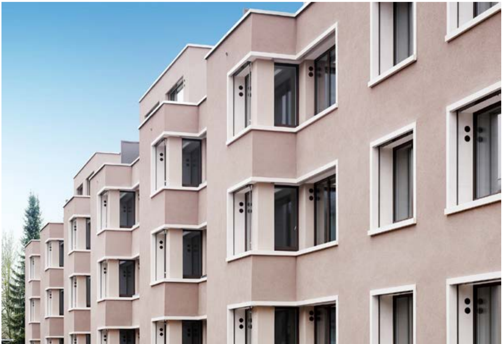
Dank der umfangreichen Erneuerungsarbeiten profitieren die Bewohner von hochmodernen Wohnungen mit viel Tageslicht.
