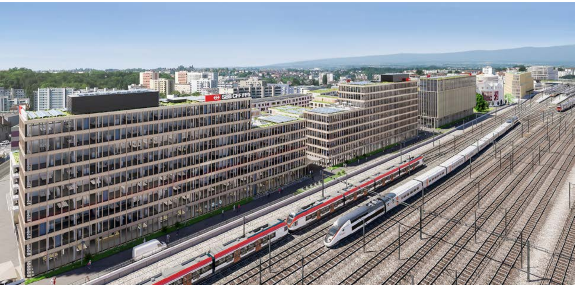
Abbildung: Ab 2021 sind die Gebäude im Parc du Simplon in Renens bezugsbereit.
